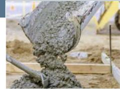
Er wird durch Brennen von Ton und Kalkstein ( $\text{CaCO}_3$ ) bei etwa  $1450^\circ\text{C}$  hergestellt und besteht aus ca. 60 % Calciumoxid, ca. 20 % Siliciumdioxid sowie Aluminium- und Eisenoxid. Beim Erhärten des Betons reagieren die Bestandteile des Zements mit Wasser. Diesen Prozess nennt man Abbinden.
