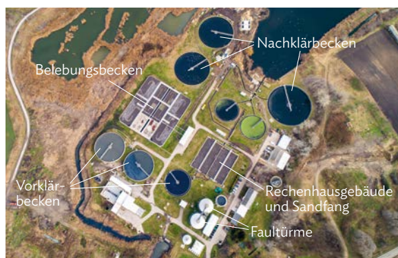
B1 Luftbild einer Kläranlage
