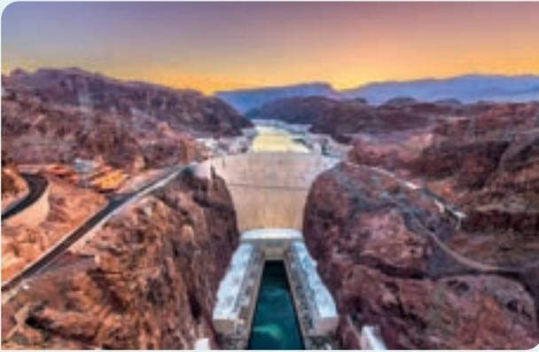
Abb. 5: Hoover Dam – eine Kombination aus Bogen- und Gewichtstaumauer
