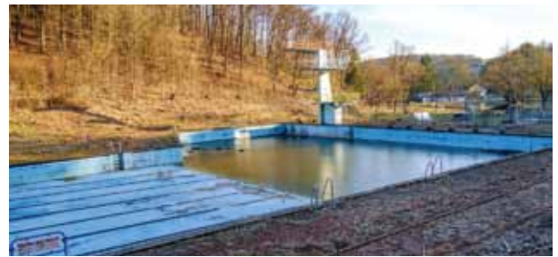
Das marode Schwimmbad in der Gemeinde Großweiler
