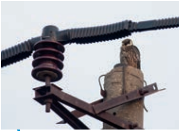
B1 Strommast mit Vogelschutz über der Stromleitung bei den Isolatoren.
