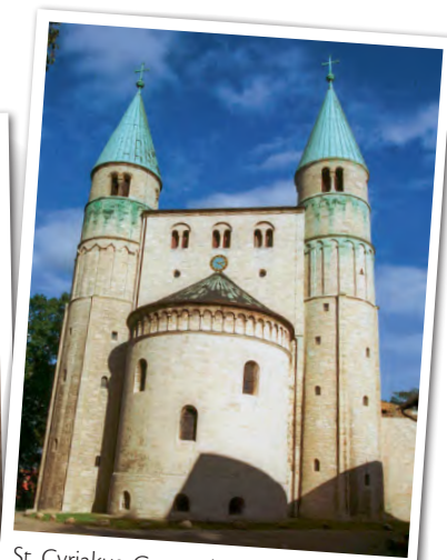
St. Cyriakus, Gernrode (Westfassade)
