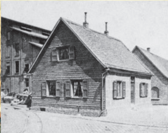
▲ Das Stammhaus der Firma Krupp in Essen.
